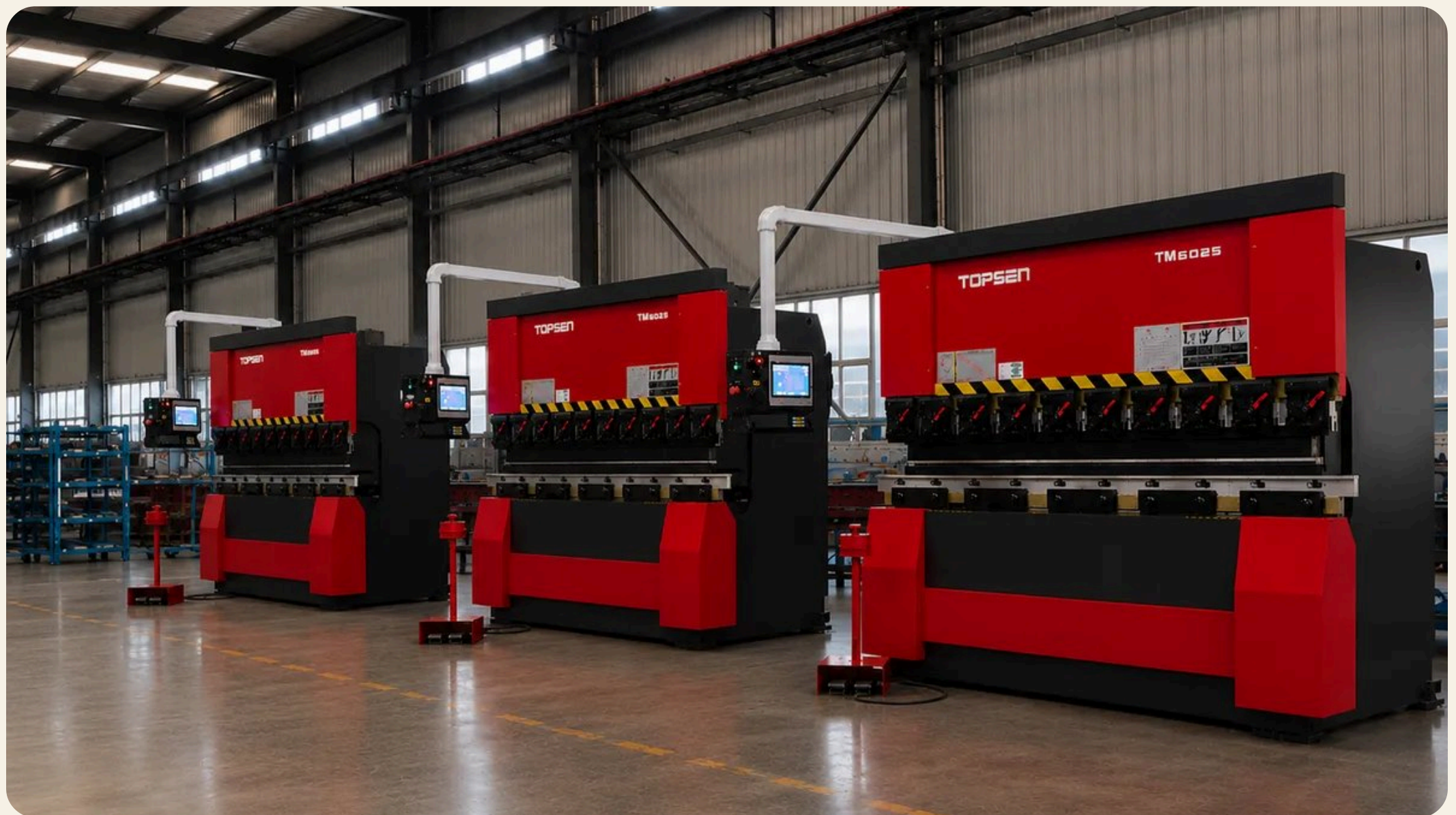
Die Biegehalle — TOPSEN 100-t-Gesenkbiegemaschinen, Biegelänge 3.100 mm, Stößelpositionierung ±0,02 mm
